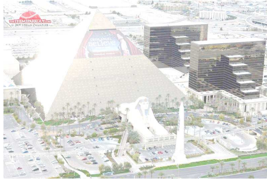
صورة (١١) توضح الواجهة الرئيسية للمبنى (١)
