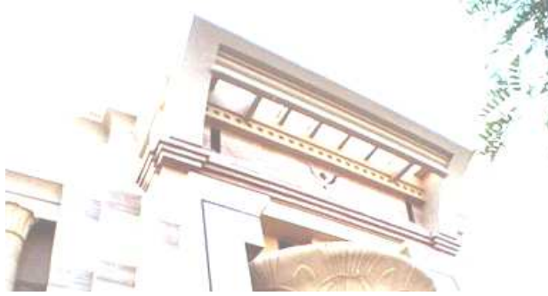
صورة (٨) شكل آخر للكورنيش بمبنى المحكمة
