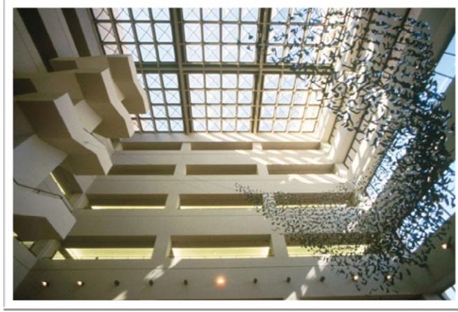
شكل رقم (٦) تغطية الفناء الداخلي بالزجاج للحفاظ على المبنى من الأحوال الجوية مع الاستفادة من الإنارة الطبيعية
